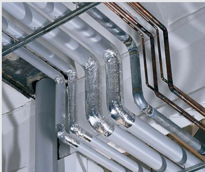
FOT. 414.1. Izolacja wykonana systemem TERMOROCK .
