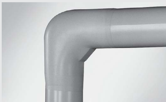
FOT. 414.5. Na zaizolowane kolano nakłada się osłonę PVC, sklejając wszystkie połączenia taśmą PVC.
