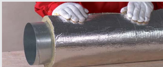
FOT. 411.3. Krok 3 – owinięcie kanału izolacją.
