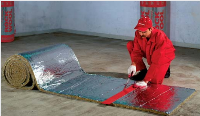
FOT. 411.5. Krok 1 – dokładne zwymiarowanie maty.
