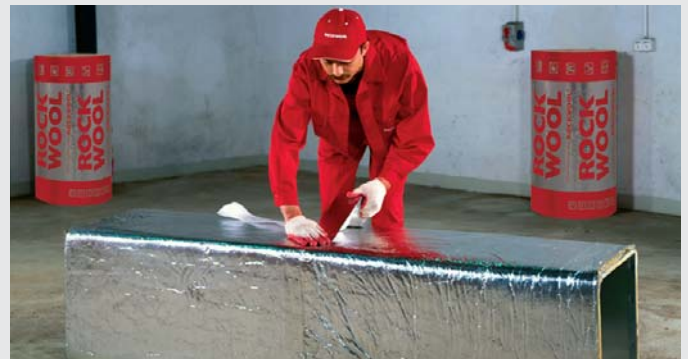
FOT. 411.8. Krok 4 – uszczelnienie taśmą aluminiową połączeń podłużnych i poprzecznych maty.
